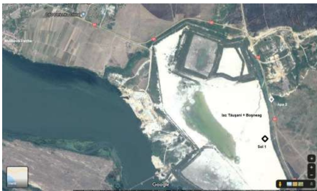
Punctul de observație APA 3 pe pârâul Boșneag și punctul de observație SOL 1 în interiorul depozitului de deșeuri miniere Taușani - Boșneag la marginea localității Moldova Nouă
