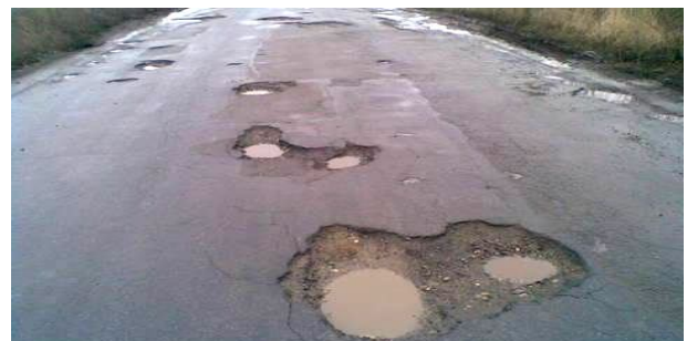
Reabilitări de „unică folosință” făcute în iunie 2010 de către Compania Națională de Autostrăzi și Drumuri Naționale pe DN 57 între Oravița și Răcășdia
