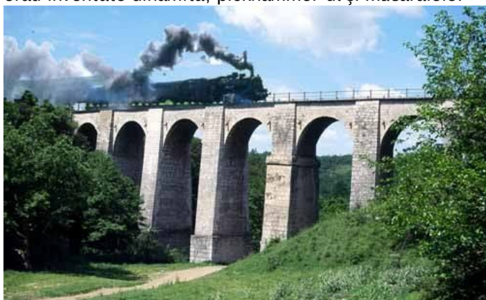
Viaduct pe linia ferată Oravița - Anina
